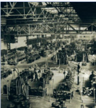
**Drahtfabrikation** | Das Klöckner-Werk in Düsseldorf produzierte Drähte und Seile für verschiedene Zwecke. In der abgebildeten Halle wurden die Drähte „gezogen“ und aufgewickelt.
